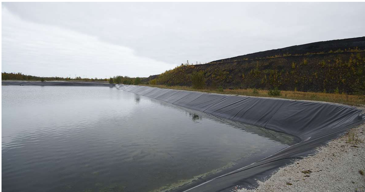
Foto 8 Settetiikide basseinid on vooderdatud põhjavett kaitsva membraankilega ja selle seisukorda kontrollitakse perioodiliselt (Foto: O. Hiimäe).
