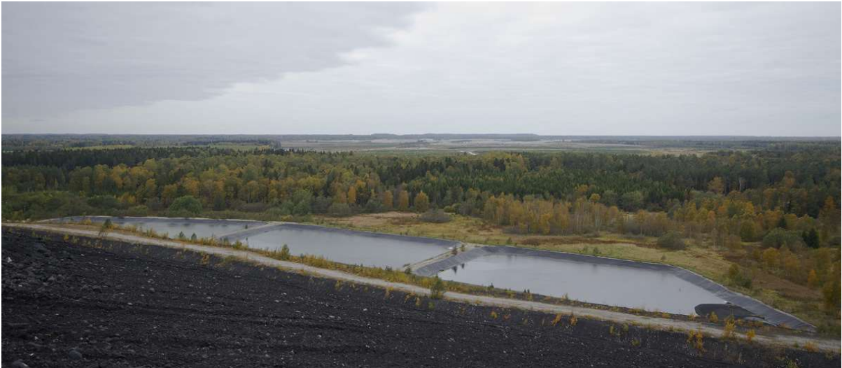
Foto 6 Vaade tuhamäe lääneküljele rajatud kolmest settebasseinist koosnevale nõrgvee ühtlustusbasseinidele (Foto: O. Hiimäe)
